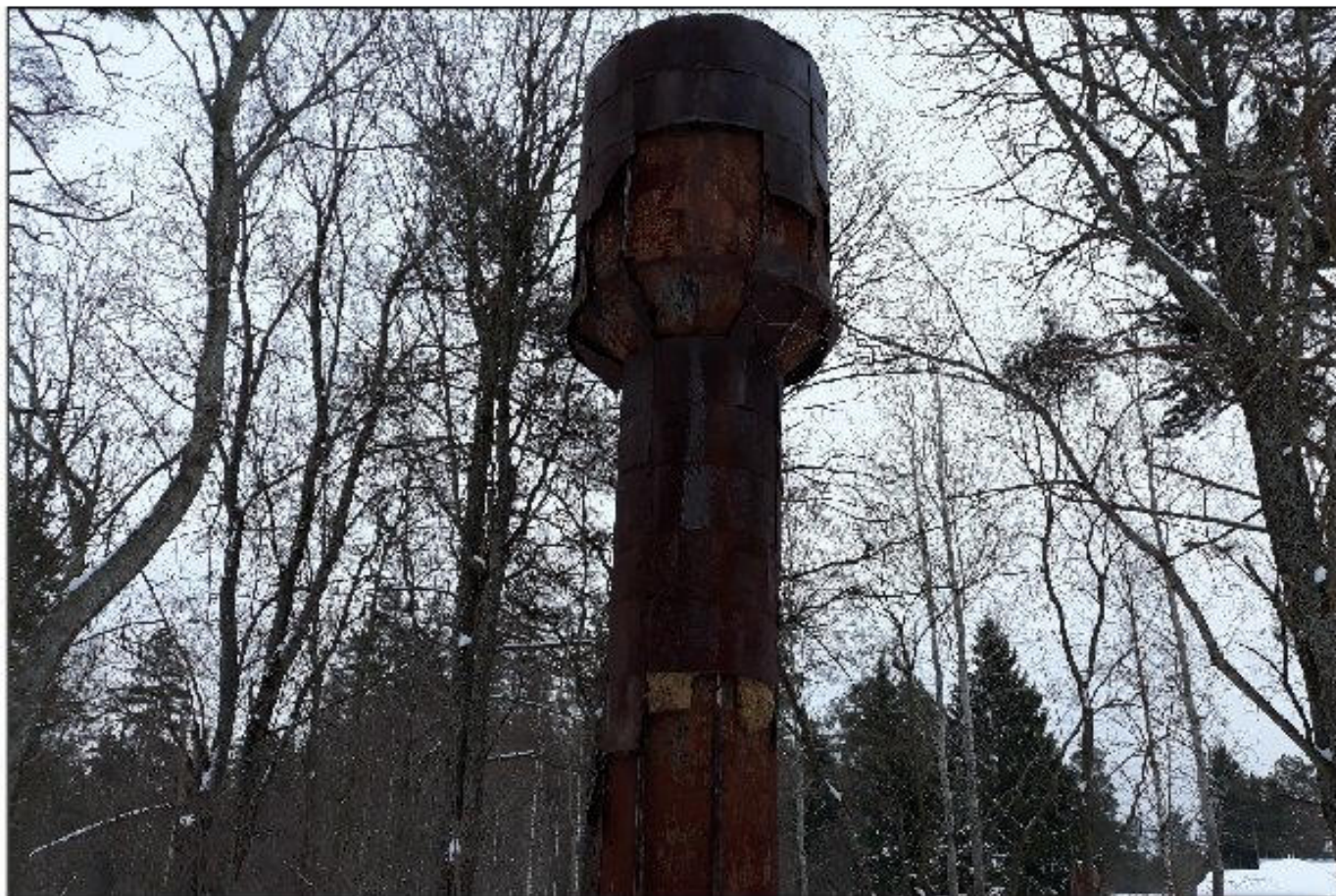
Рисунок ВС-19 – Водонапорная башня в д. Светлое
