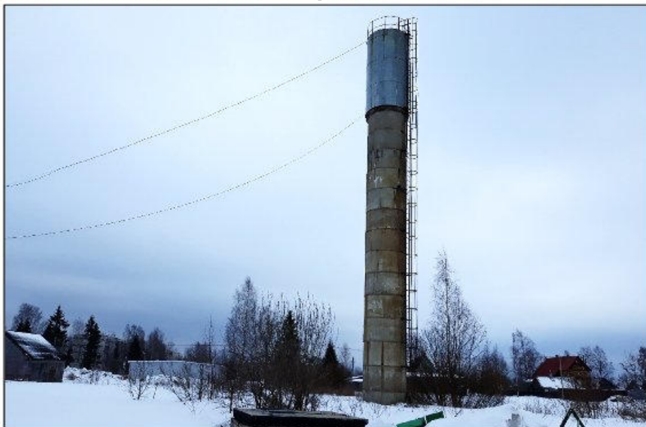
Рисунок ВС-1.6 – Водонапорная башня д. Красноозерное
